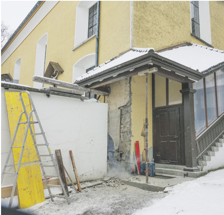
Die Klostermauer erhält einen neuen Durchlass (Bild links). – So soll sich die neue Pforte dereinst ins Bild einfügen.
